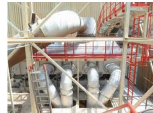
FLIESSBETT-VORWÄRMER BEI DER FILTERANLAGE IM WERK BREITENAU (Ö)
