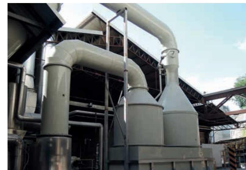
infrastrutture produttive con un'attenzione particolare all'ambiente e sicurezza, anello imprescindibile dell'innovazione.
